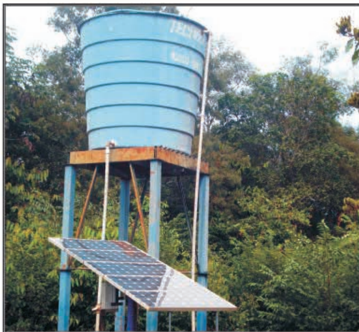
Caixa d'água com painel solar que garante energia para a bomba d'água
