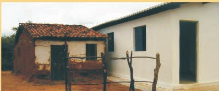
Moradias de pau-a-pique dão lugar a casas decentes. Investimentos vão beneficiar quatro mil pessoas
