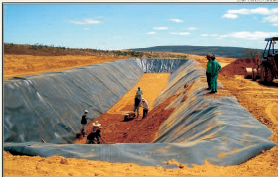
A Estrutura do aterro conta ainda com uma vala séptica específica para destinar resíduos de saúde
