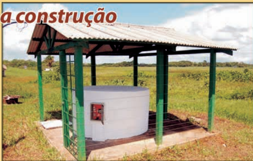
Um dos quatro poços construídos: determinação para concluir a obra
