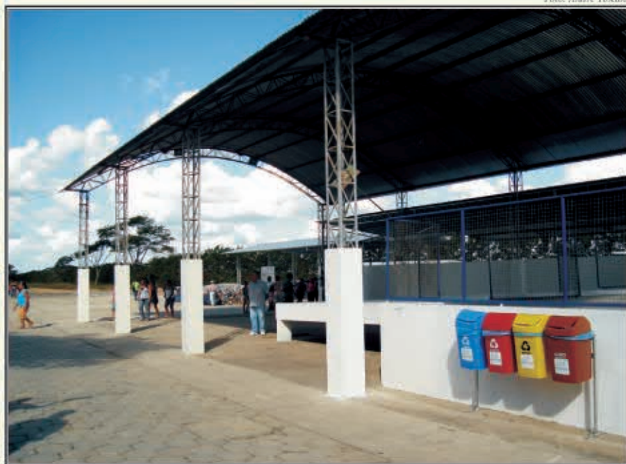
Galpão de separação do material reciclável: renda para novos investimentos
